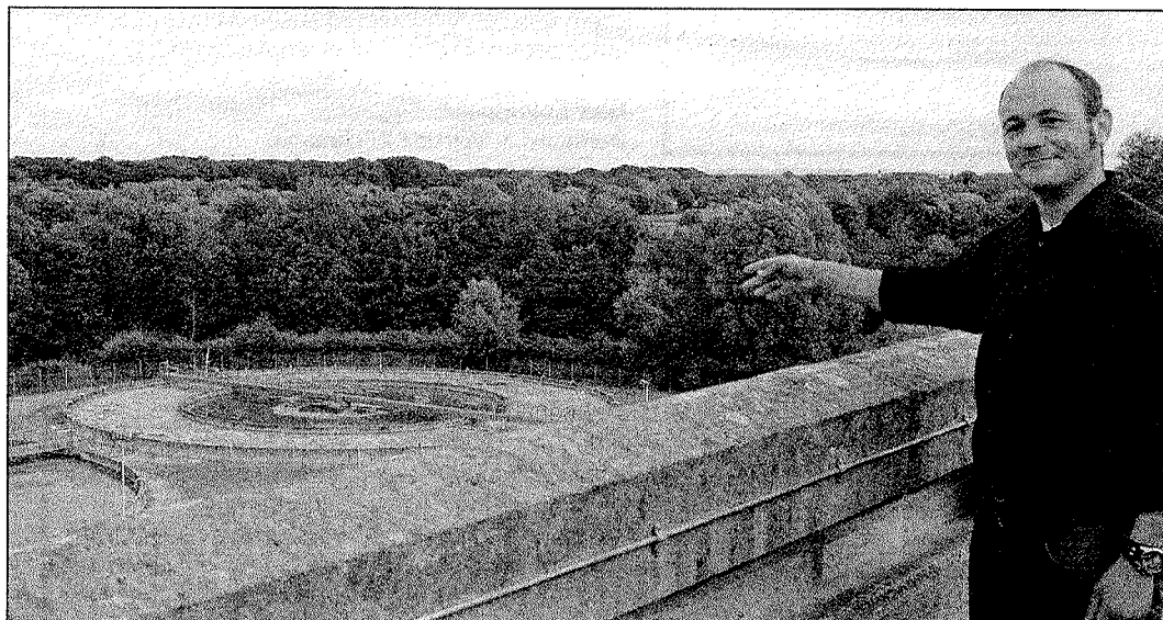
Betriebsleiter Thorsten Holtkötter sorgt im Zentralklärwerk am Hellinghäuser Weg für einen reibungslosen Ablauf. Die beiden Belebungsbecken im Hintergrund wurden in den 90er Jahren nachgerüstet.
