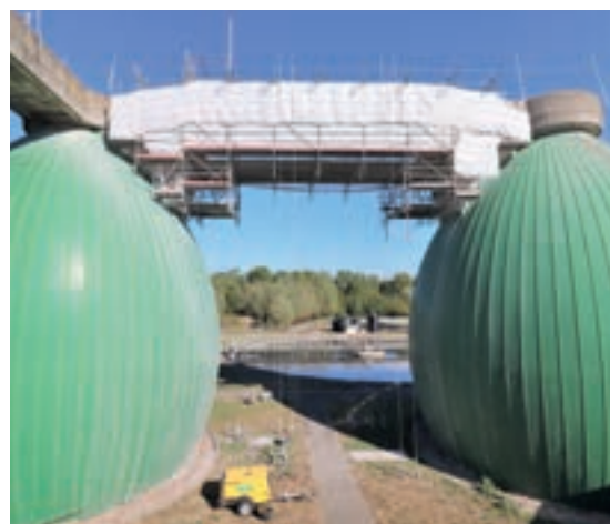
Baugerüst zwischen den Faultürmen
